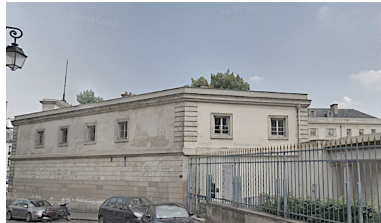
Photographie actuelle de la Boîte à claque depuis la rue Descartes
